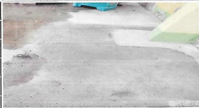
Foto 9: Reparación de plancha.
