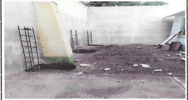
Foto 2: Proceso de reparación de torta de cemento.
