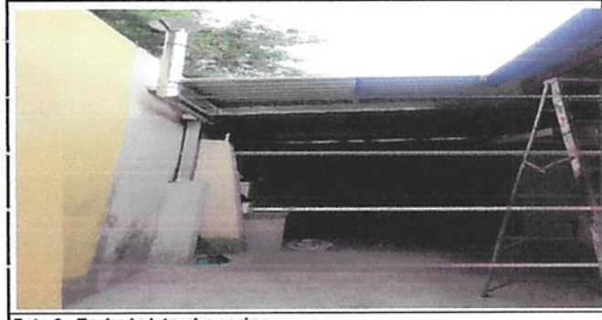
Foto 6: Techado lateral a cocina.
